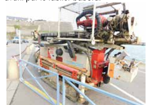
L'engin de forage qui sera installé.
